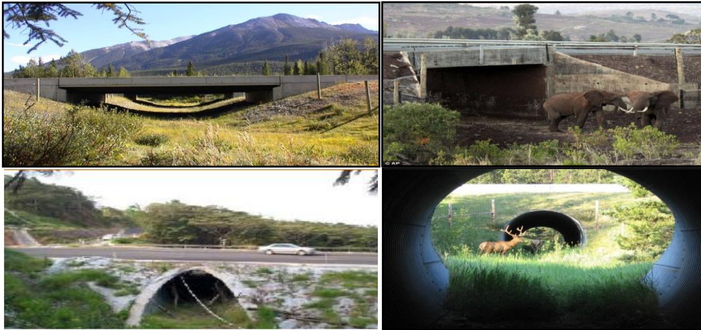
உரு 5.2: விலங்கு இயக்கத்தை எளிதாக்கும் சுரங்கப்பாதைகளோடு பாலம் மற்றும் மதகுகள் வடிவமைக்கப்பட்டுள்ளது
